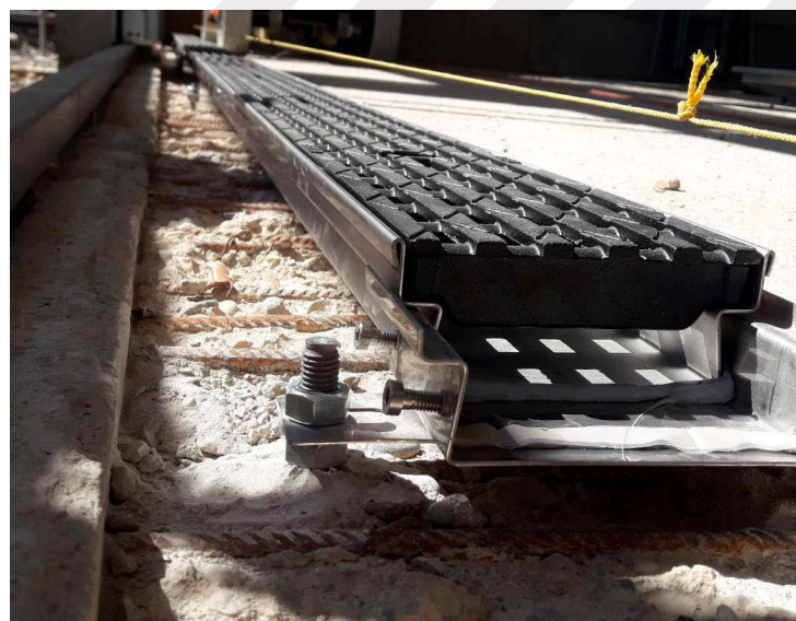
← Caniveau avec supports de montage et de pose.
