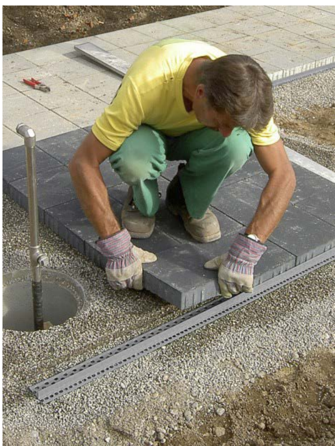
↑ Pose de pavés en béton
