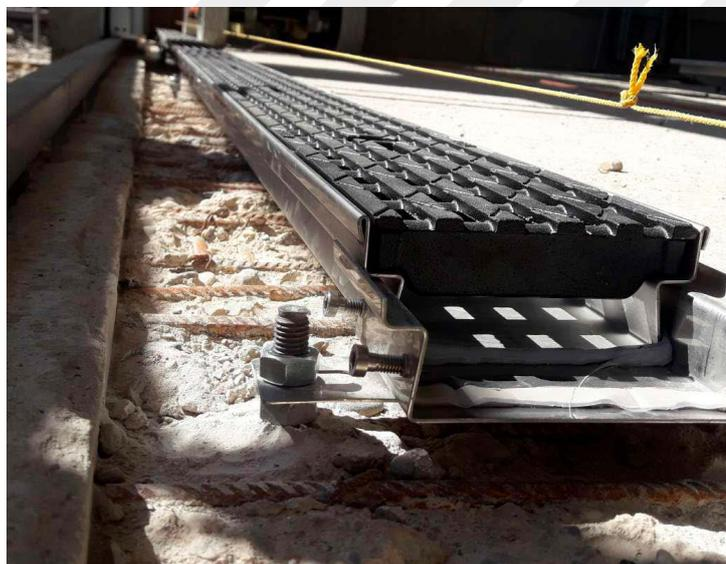
← Rinne mit Montagestütze und Einbaualterung
