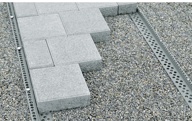
← Wegbau mit Betonplatten
