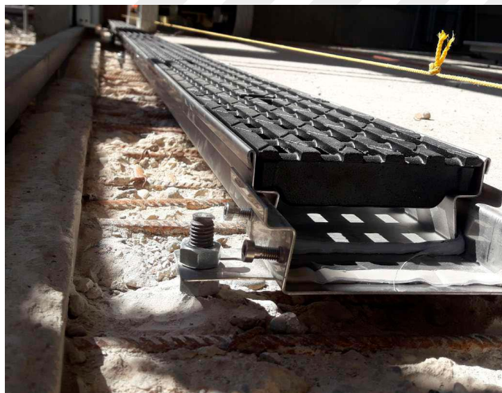
← Rinne mit Montagestütze und Einbaualterung
