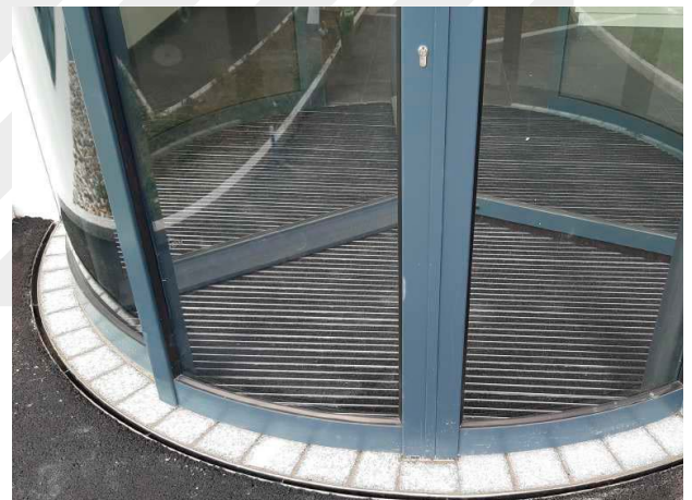
↓ Radiusrinne mit Schlitzaufsatz im Radius.
