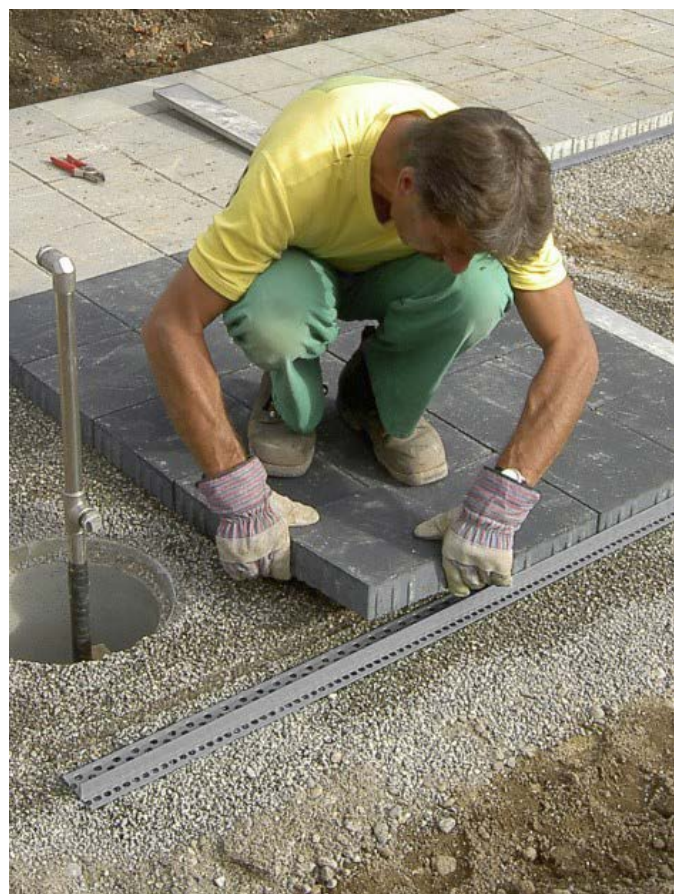
↑ Montage der Betonplatten
