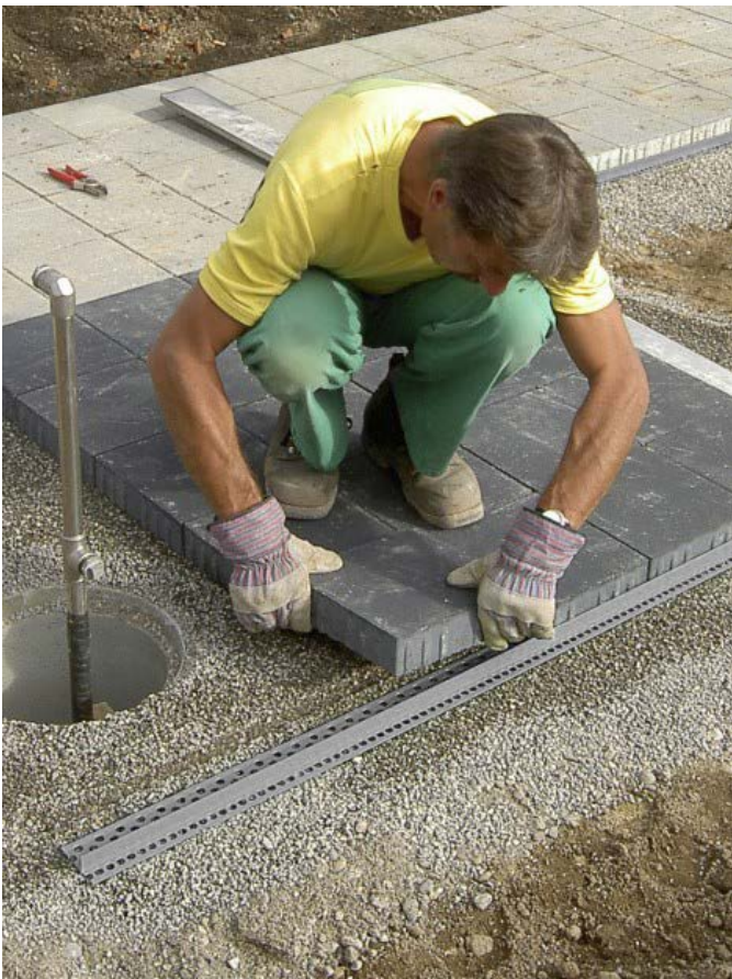
↑ Pose de pavés en béton
