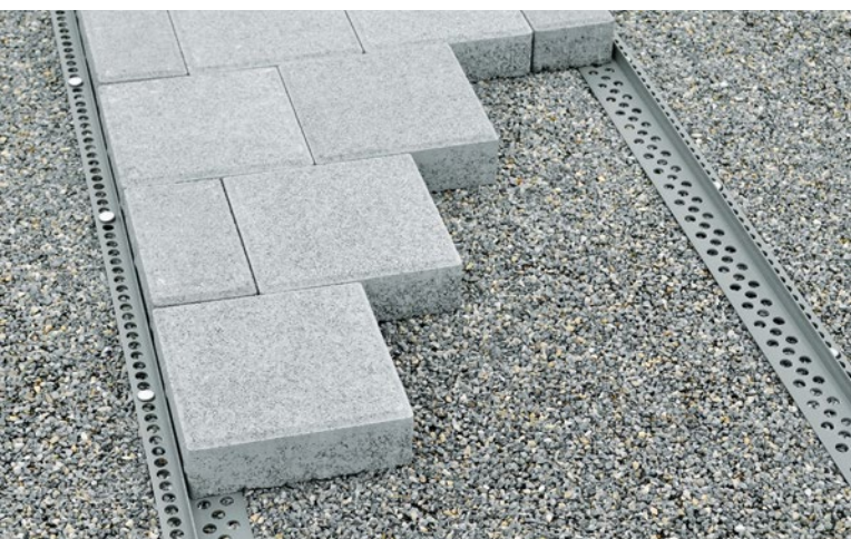
← Wegbau mit Betonplatten
