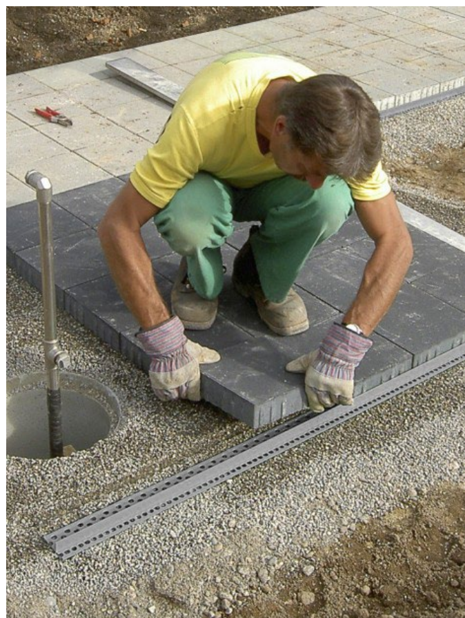
↑ Montage der Betonplatten
